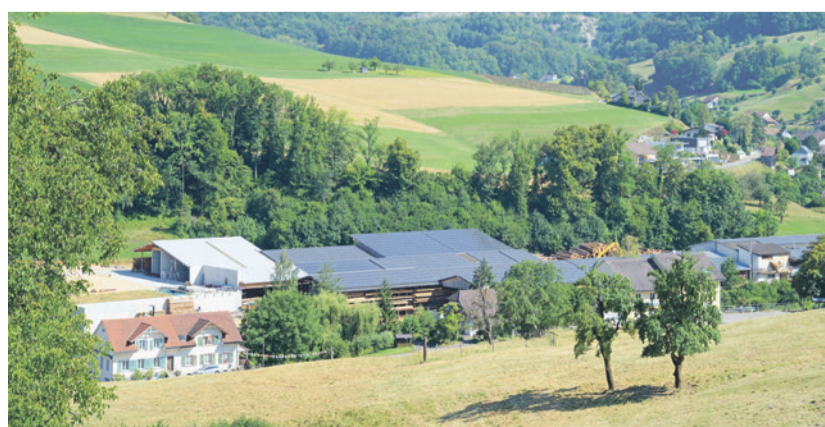
Die Photovoltaikanlage der Sägerei umfasst 4250 Quadratmeter. Bild ch.
